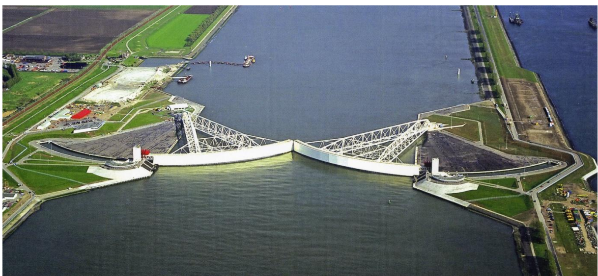
Figuur 11: De Maeslantkering gesloten. Foto: Beeldbank RWS
